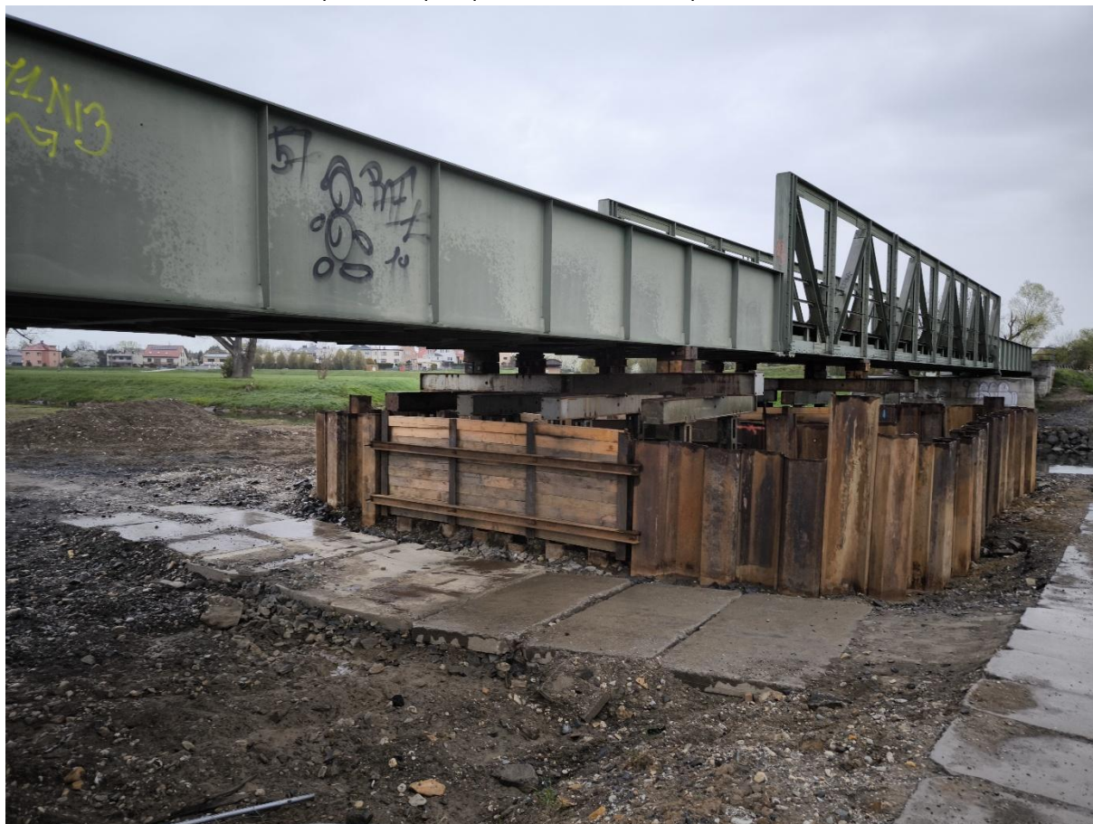
Poškození mostu v km 26,783 – provizorní podepření v místě druhého pilíře
