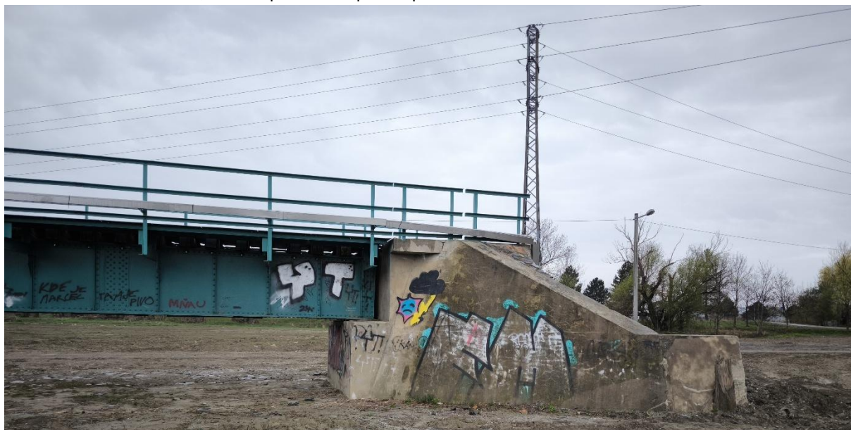
Poškození mostu v km 26,880 – odplavení náspu za opěrou
